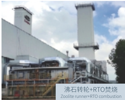
图 28 广汽本田废气处理装置 (图源:广汽本田2020年绿色发展报告)
